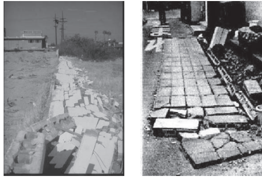
Figura C 10.37. Prăbușirea gardurilor de incintă
