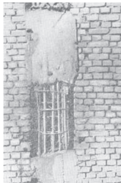
Figura C 8.14. Defecte de turnare la stâlpișori (se observă și lipsa ștrepilor)
