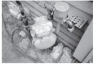
Figura C 10.43. Dispozitiv automat (valvă) pentru oprirea alimentării cu gaz natural
