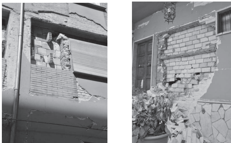
Figura C 10.23. Zidărie dublu strat cu legături necorespunzătoare între straturi (L'Aquila 2009)
