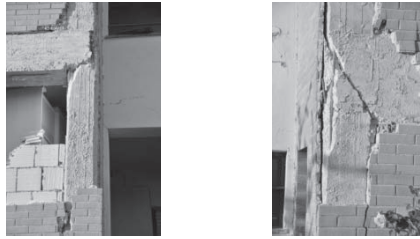
Figura C 10.18. Avarierea nodurilor de cadru provocată de panourile de zidărie (L'Aquila 2009)
