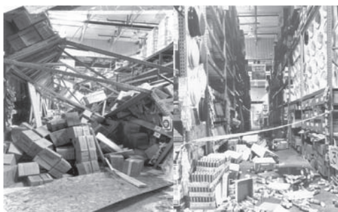
Figura C 10.52. Avarii ale rafturilor etajate în depozite
