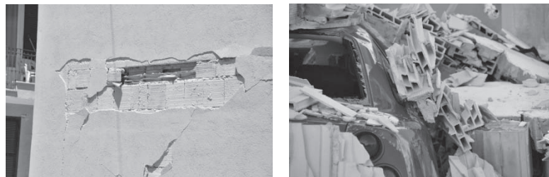
Figura C 10.21. Avarierea panourilor de umplură din elemente cu goluri și pereți subțiri [ Fred Turner, L'Aquila]
