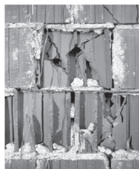
Figura C 8.4. Detalii de rupere casantă pentru zidărie cu elemente cu goluri verticale armate [Tomazevic, M., Bosiljkov, V., Lutman, M. Masonry research for Eurocodes , Meeting CIB W023, Wall structures, Padova 2003]
