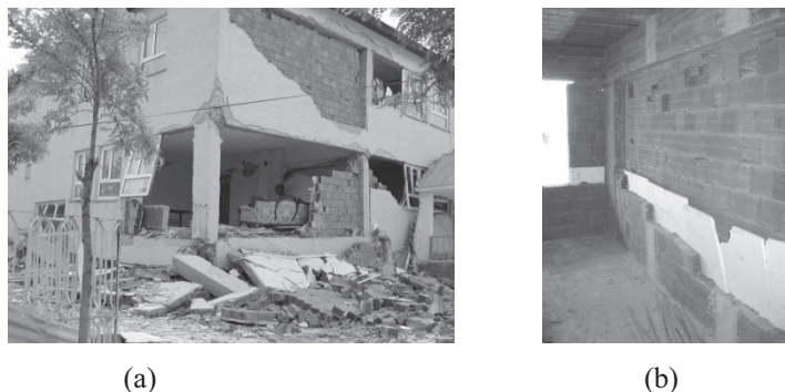
Figura C 10.22. Zidărie dublu strat fără legături între straturi (Turcia 1999)
