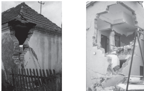
Figura C 8.19. Expulzarea zidăriei la colțuri la zidăria fără stâlpișori
