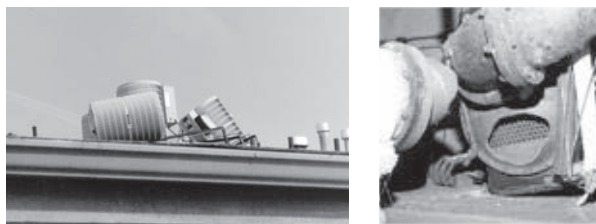
Figura C 10.48. Avarii ale aparatelor de condiționare
