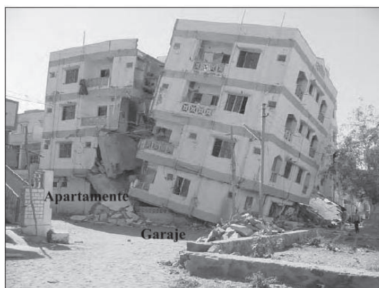
Figura C 10.16. Distrugerea completă a unei clădiri etajate din cauza dispunerii necontrolate a panourilor de zidărie (cutremurul de la Bhuj)
