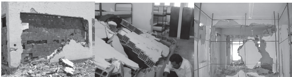
Figura C 8.6. Distrugerea panourilor de umplutură din zidărie din elemente cu goluri orizontale (Bingol, Turcia 1999)
