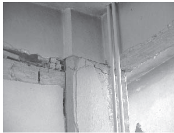
Figura C 8.15. Panou de zidărie nemodulat, completat cu alt tip de elemente pentru zidărie
