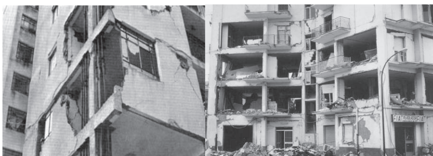
(a) rezemați pe console (b) înrâmați în cadre de beton armat
