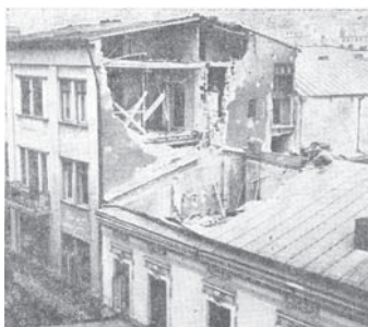
Figura C 10.10. Căderea calcanului a avariat clădirea vecină București, 1977
