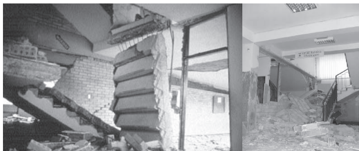
Figura C 10.38. Ruperea scării și/sau prăbușirea pereților de la casa scării împiedică folosirea căilor de evacuare/acces
