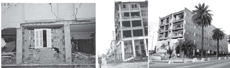
Figura C 10.17. Expulzarea fațadelor înrămate în cadre de beton armat
